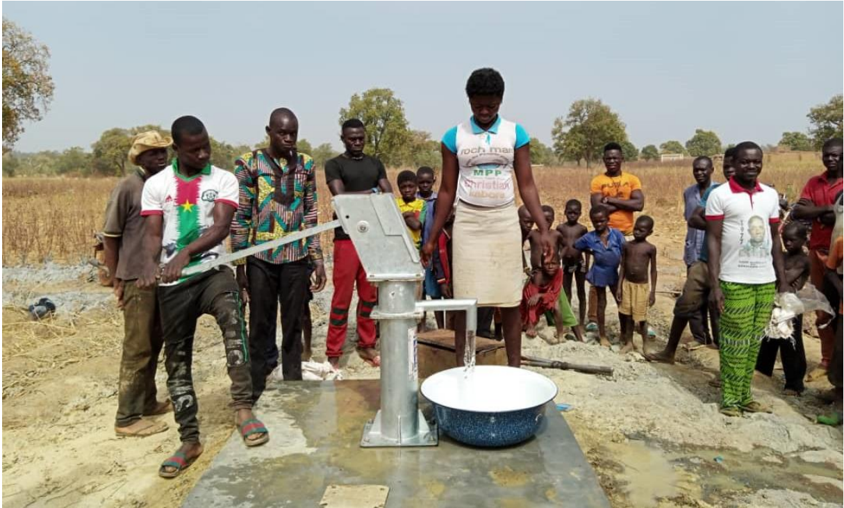
Baakounteng 20 décembre 2020 – installation de la pompe et premiers essais de pompage
