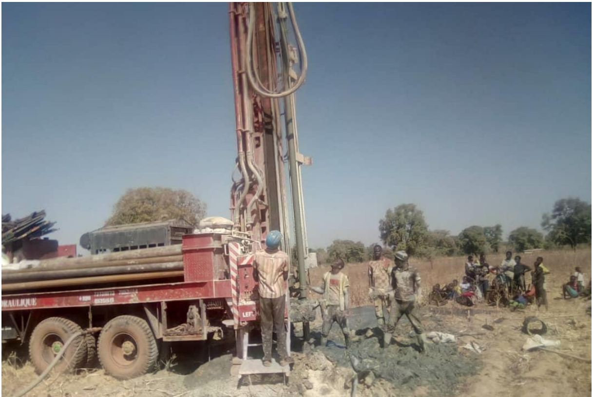
Travaux de foration
